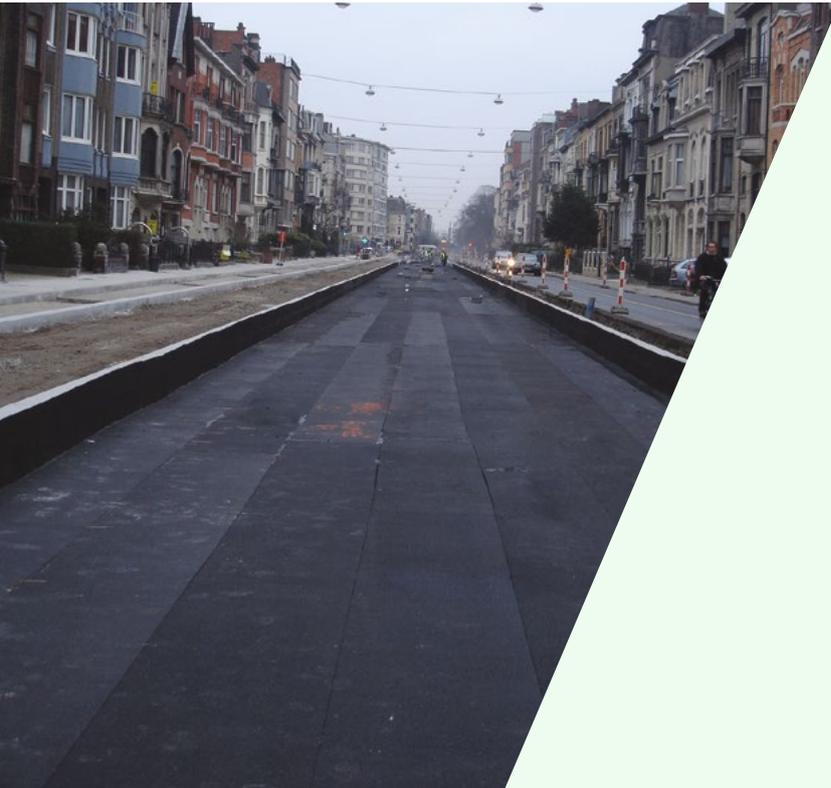
Le FSM de Pandrol est un système très performant pour l'atténuation des vibrations. Facile à installer, sans entretien et compatible avec tous les types de rails et de voies, il vise à réduire les coûts tout au long du cycle de vie de la voie ferrée.
