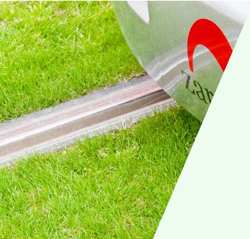
Le QTrack® Pandrol est un système de voie noyée sans ballast, qui fournit un excellent support vertical et latéral du rail en ligne droite et dans les courbes.
