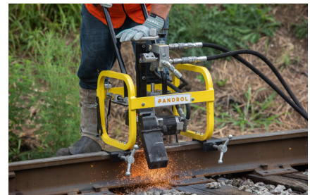
Meulage à l'aide d'une meuleuse hydraulique.
