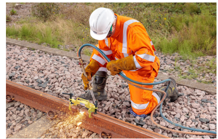
Oxycoupage à l'aide d'un outil de découpe oxy-gaz.
