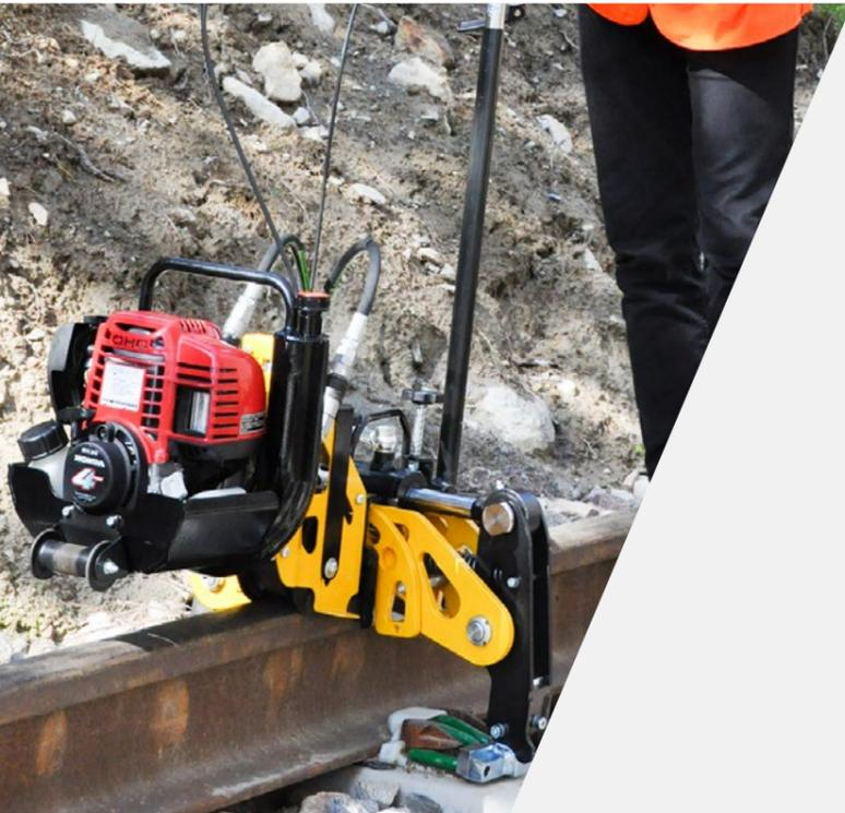
A instaladora de grampos CD100 foi projetada para operações de instalação e extração de grampos Pandrol. Compacta e leve, ela pode ser transportada com facilidade até o local por uma só pessoa.
