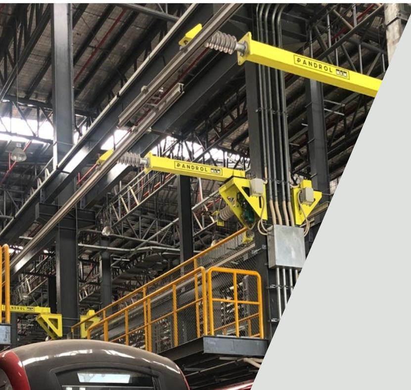
La caténaire escamotable de Pandrol est un système ingénieux de caténaire rigide amovible conçu pour faciliter et sécuriser les opérations de maintenance sur le matériel roulant.
