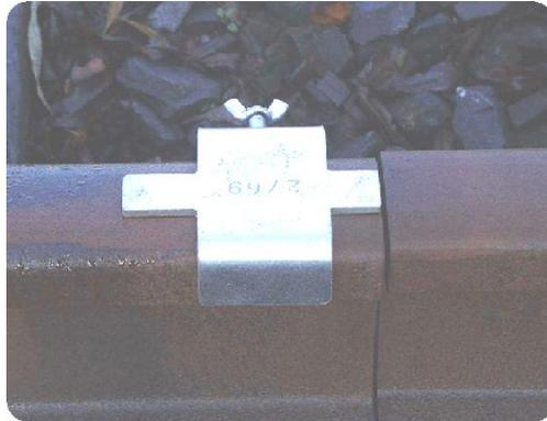
Positionner le bras support en contact avec le talon du gabarit de telle sorte que l'axe de fixation de la tronçonneuse soit côté gabarit et serrer l'étau énergiquement.
