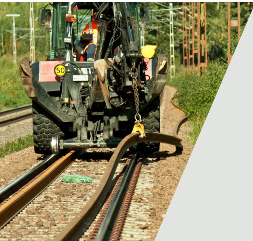
Les pinces à rail de Pandrol sont utilisées pour installer et entretenir les longs rails soudés (LRS). Les pinces à rail se fixent automatiquement sur le rail déplacé et sont conçues pour être attachées à tous les types de matériel de transport et de dépose des rails.
